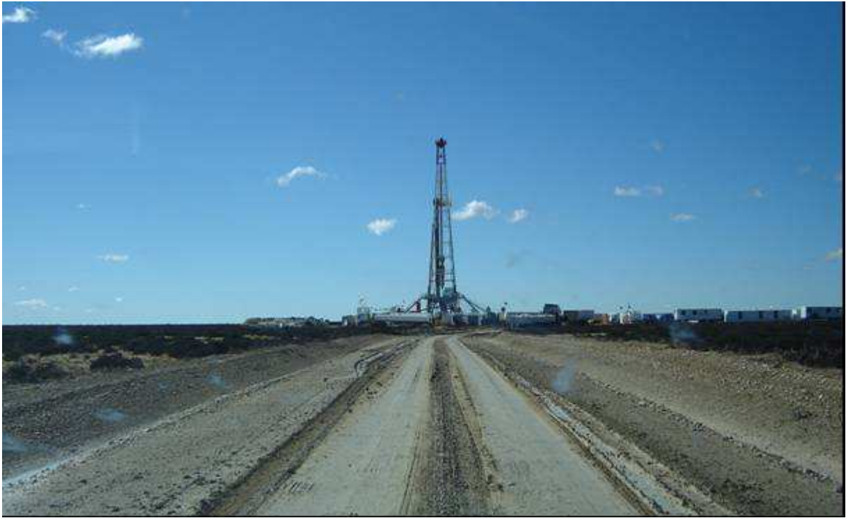
Llegando al pozo. Se observa el Equipo 20 de Quintana Well Pro.
