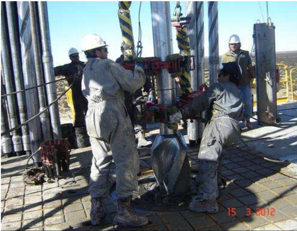
Operarios en boca de pozo
